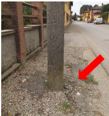
Foto 3 - Via Maggiore - ostruzione nella sezione di passaggio
