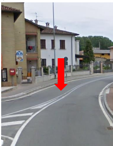
Foto 7 – Circonvallazione C – attraversamento pedonale mancante
