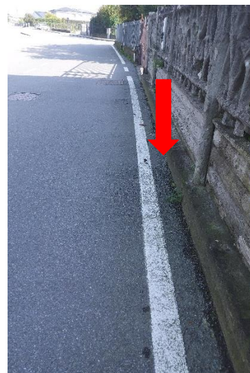
Foto 2 – Via della Zecca – banchina con larghezza < 90 cm
