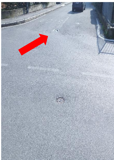
Foto 1 – Via della Zecca – attraversamento pedonale mancante
