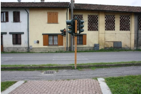
Impianto 4 - Incrocio Gradella: pedonale senza sbarchi accessibili Impianto 6 - Incrocio Barbuzzera: pedonale senza sbarchi accessibili
