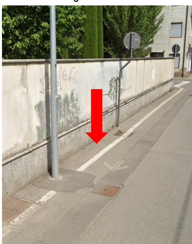
Foto 3 – Circonvallazione A – banchina di larghezza < 90 cm
