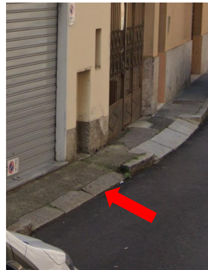
Foto 4 – Via Milano – marciapiede con larghezza < 90 cm
