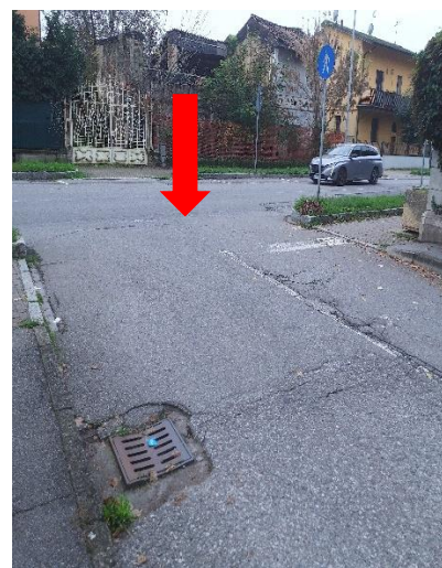
Foto 2 – Via Torchiera – attraversamento pedonale mancante
