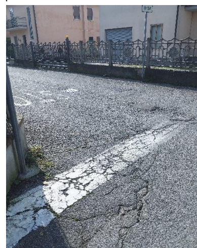
Foto 6 – Via D'Annunzio – attraversamento pedonale mancante
