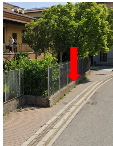
Foto 6 – Circonvallazione B – marciapiede con larghezza < 90 cm
