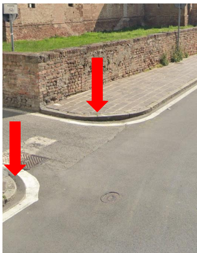
Foto 5 – Via Castello – sbarco pedonale con dislivello
