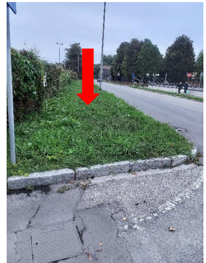
Foto 2 - De Gasperi - pavimentazione mancante
