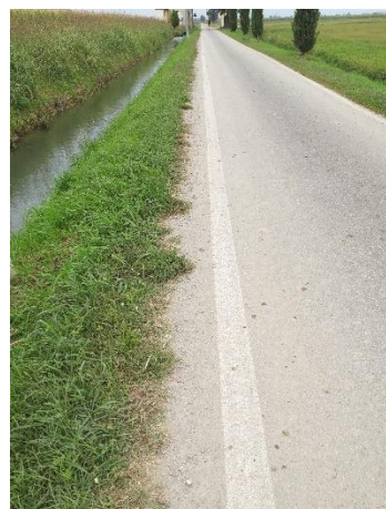
Foto 6 – Cimitero – banchina non transitabile
