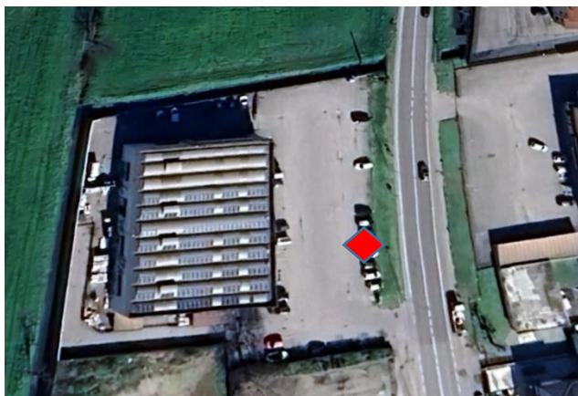
Immagine 1 - Vista aerea (Fonte: Google Earth 2024)
