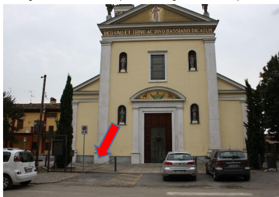
Foto 1 – Stallo disabili: sbarco lato guida – pavimentazione non compatta – BA. Sagrato e Chiesa non accessibile per ostacoli – BA.
