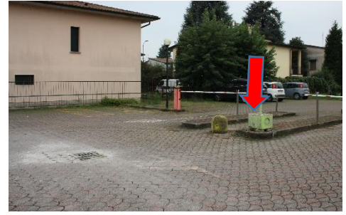
Foto 2 - Ingresso pedonale con ostacolo - BA
