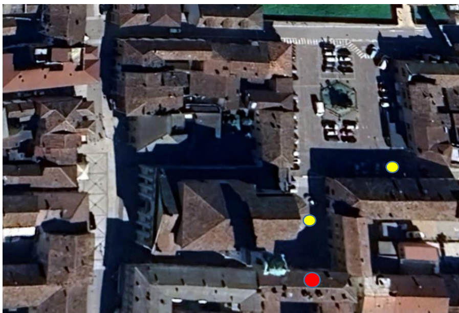
Immagine 1 - Vista aerea (Fonte: Google Earth 2024)
