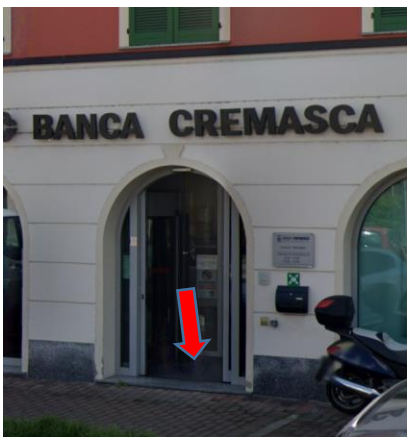
Foto 1 - Ingresso con dislivello < 2 cm – BA
