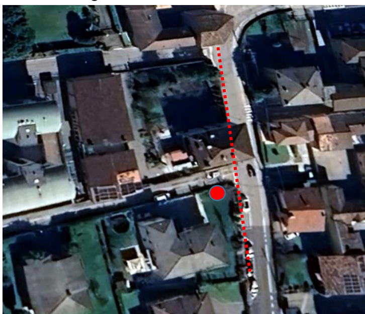
Immagine 1 - Vista aerea (Fonte: Google Earth 2024)
