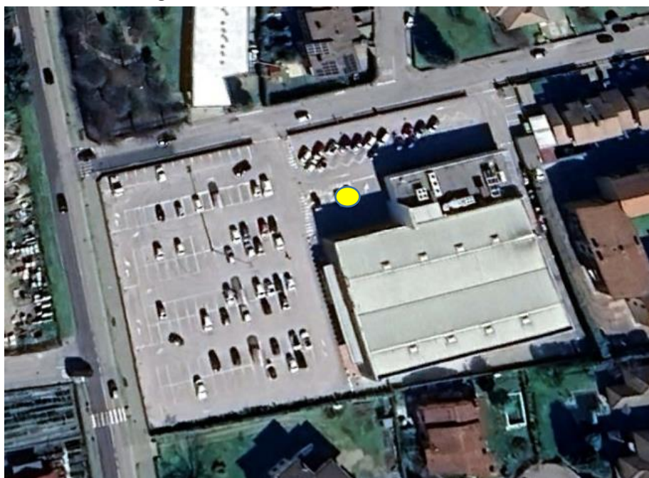
Immagine 1 - Vista aerea (Fonte: Google Earth 2024)
