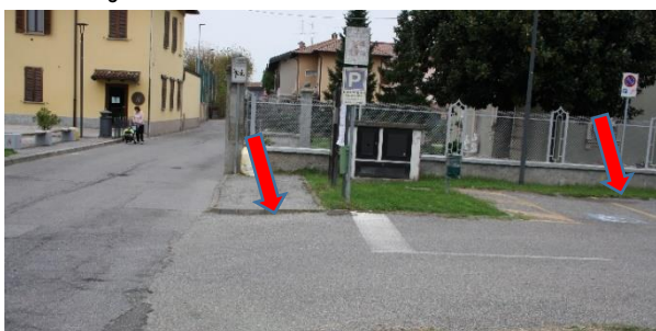
Foto 3 – Via Gradella: marciapiede interrotto; stallo disabili
