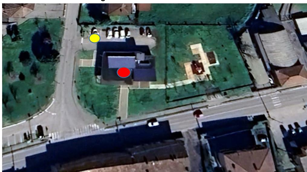
Immagine 1 - Vista aerea (Fonte: Google Earth 2024)
