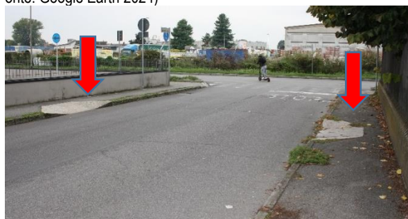
Foto 2 – Scivoli costituiscono ostruzione sezione passaggio e BA
