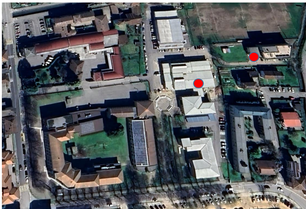
Immagine 1 - Vista aerea (Fonte: Google Earth 2024)
