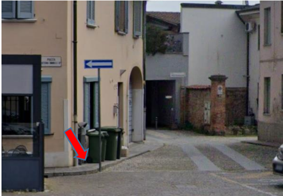
Foto 4 - P.zza V. Emanuele: marciapiede con dislivello - BA
