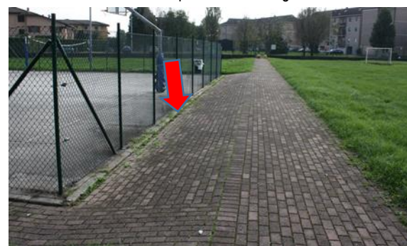
Foto 4 – Percorso interno – pendenza trasversale fronte campo gioco > limite norma – BA
