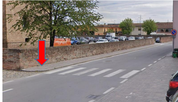
Foto 3 - Via Castello: attraversamento pedonale con doppio dislivello - BA
