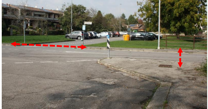
Foto 3 - Attraversamenti pedonali non attrezzati e segnalati - BA
