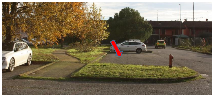
Foto 1 - Segnaletica orizzontale stalli sosta mancante. Stallo disabili non segnalato
