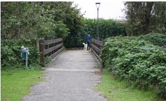
Foto 3 e 4 – Dislivello tra percorso e ponticello > 2 cm – BA.
