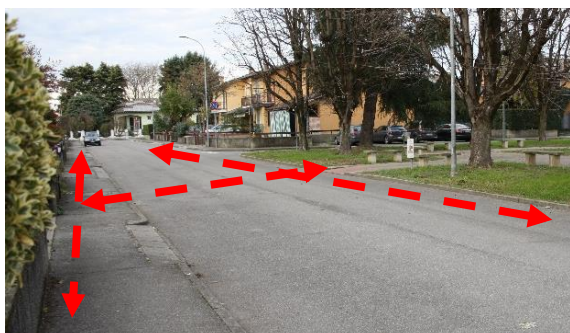
Foto 1 – Ingresso giardino: attraversamento e percorso pedonale non segnalati
