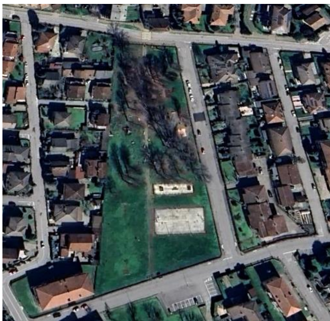
Immagine 1 - Vista aerea (Fonte: Google Earth 2024)
