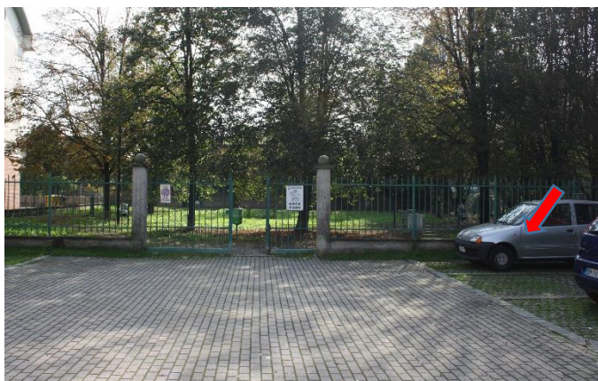
Foto 1 – Ingresso dal parcheggio – stallo disabili non segnalato; pavimentazione stalli non conforme - BA
