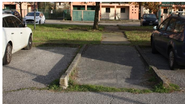
Foto 2 – Percorso pedonale pavimentato con scivoli di raccordo
