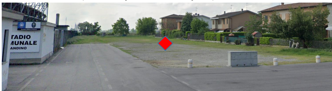
Foto 3 – Panoramica area parcheggio: stalli non pavimentati e non segnalati; stallo disabili non segnalato.
