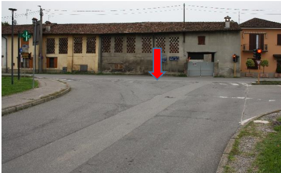
Foto 1 – Via Gradella - attraversamento pedonale – lunghezza > 8 m senza isola salvagente - BA
