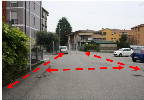
Foto 2 – Incrocio Via Fontana/Negri: percorsi e attraversamenti pedonali non segnalati
