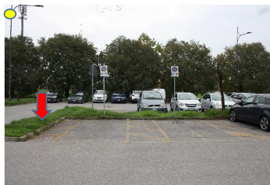
Foto 4 – Stallo riservato: ostacolo laterale aiuola non pavimentata
