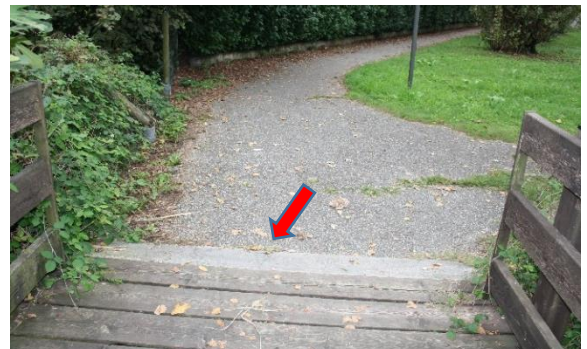
Foto 2 – Pavimentazione dissestata da apparati radicali
