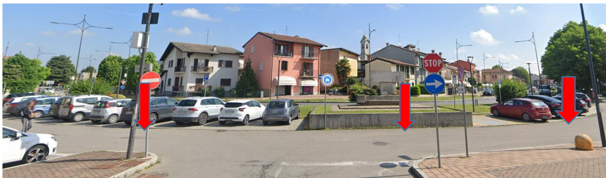
Foto 1 – Segnaletica orizzontale percorso pedonale lato parcheeggio e attraversamenti pedonali
