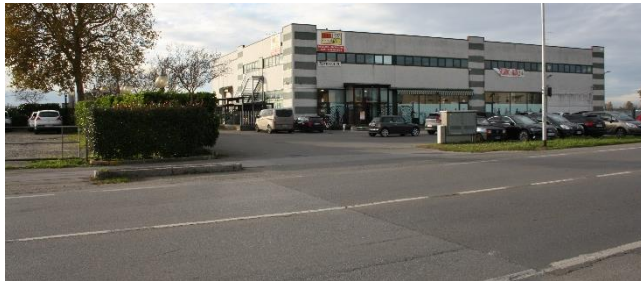
Foto 1 – Ingresso al parcheggio – stalli non segnalati
