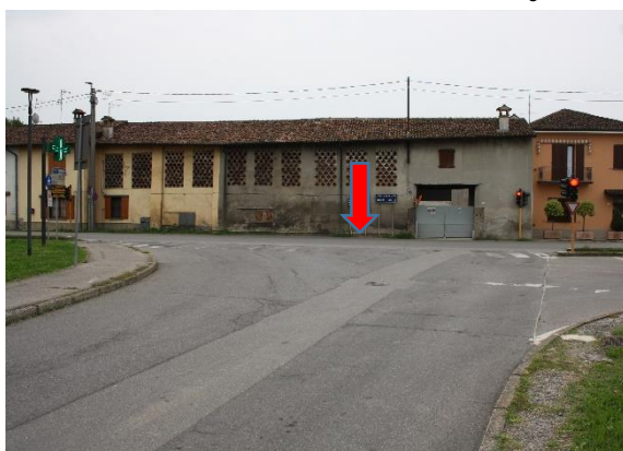
Foto 1 – Via Gradella - attraversamento pedonale – lunghezza > 8 m senza isola salvagente.
