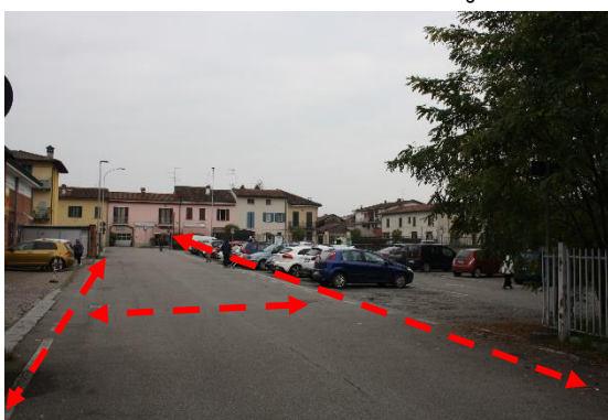
Foto 1 – Parcheggio pubblico: percorso e attraversamento pedonale non segnalati
