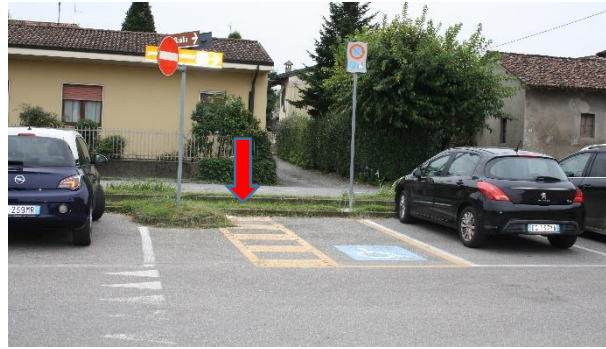
Foto 2 – Percorso pedonale non accessibile da stallo disabili
