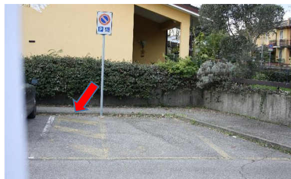
Foto 4 – Stallo disabili: marciapiede non accessibile - BA
