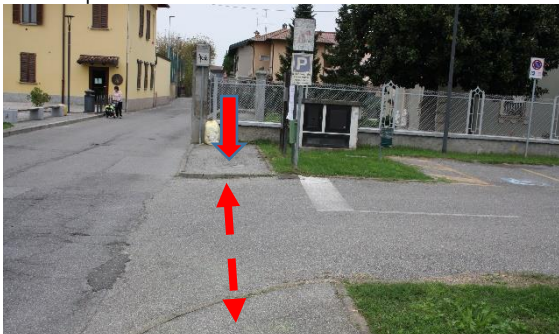
Foto 3 – Attraversamento pedonale mancante: interruzione Marciapiede, sbarco non con dislivello
