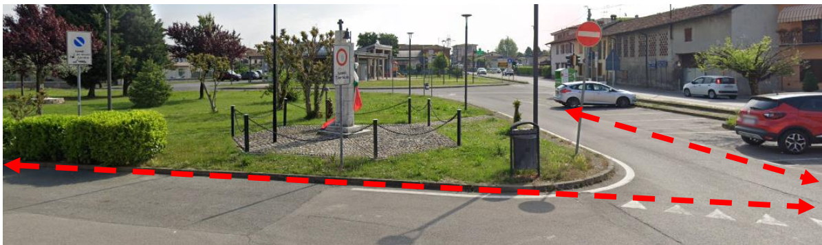
Foto 3 – Percorso e attraversamento pedonale non segnalati
