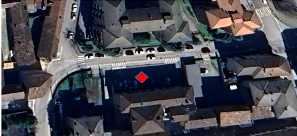
Immagine 1 - Vista aerea (Fonte: Google Earth 2024)
