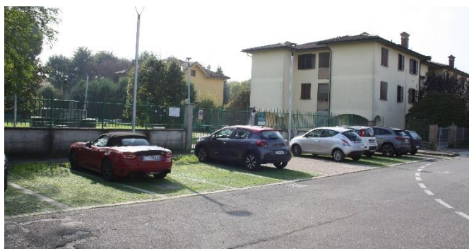
Foto 4 - Stallo disabili non segnalato - piano di calpestio non accessibile - BA
