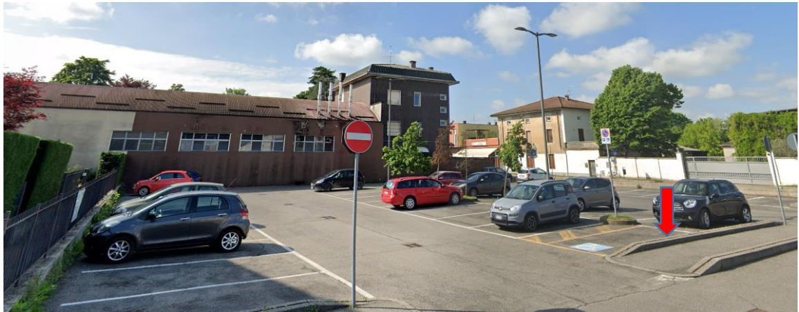
Foto 1 – Stallo disabili a norma – cordolo marciapiede con doppio dislivello – BA.
