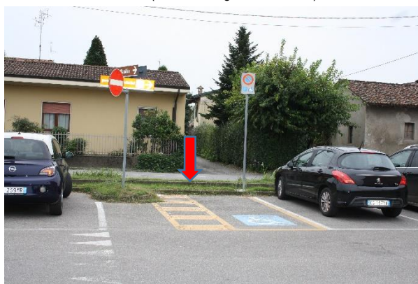
Foto 2 – Percorso ciclo-pedonale non accessibile da stallo disabili
