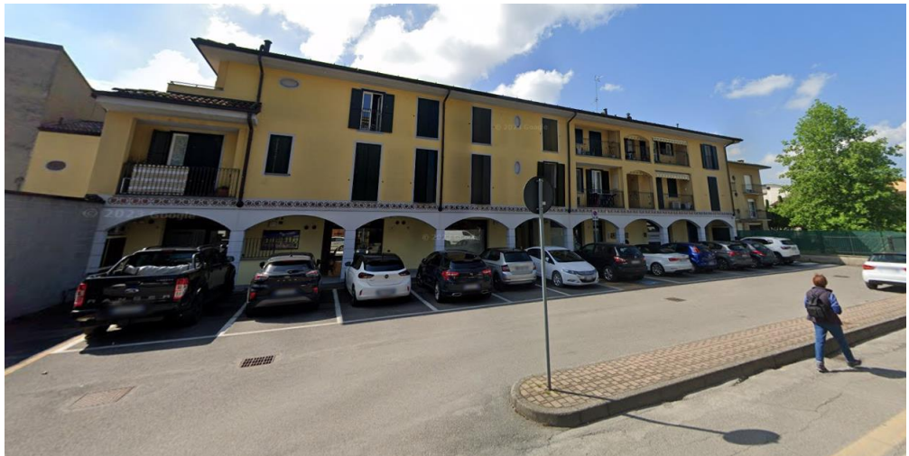
Foto 1 – Vista parcheeggio da via Circonvallazione
