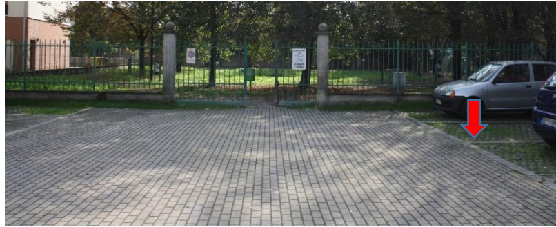
Foto 1 – Area parcheggio – pavimentazione stalli non conforme - BA
