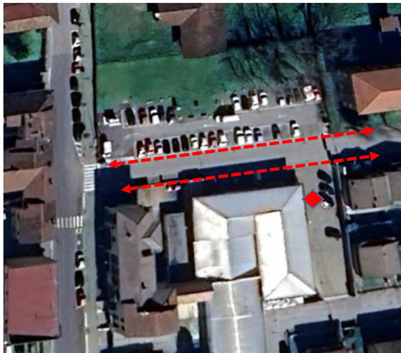
Immagine 1 - Vista aerea (Fonte: Google Earth 2024)
