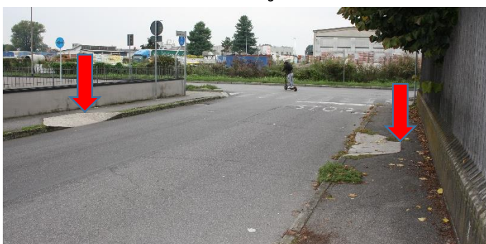
Foto 2 – Scivoli restringono sezione passaggio < 90 cm - BA
