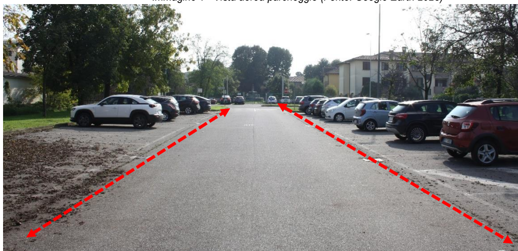
Foto 1 – Vista parcheggio: stallo disabili non segnalato; percorso pedonale non segnalato
