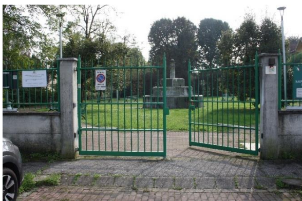
Foto 1 - Ingresso: dislivello parcheggio - marciapiede - BA
