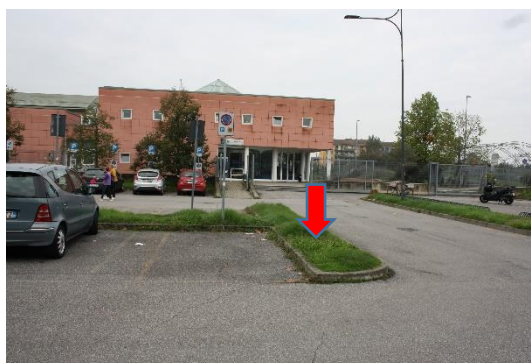
Foto 3 - Stallo riservato: ostacolo laterale aiuola non pavimentata
