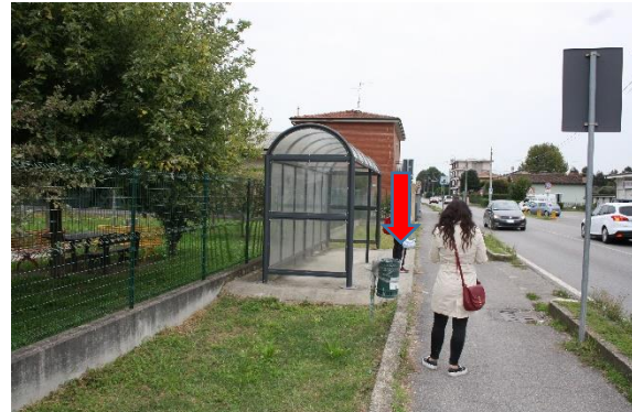
Foto 2 – Fermata bus TPL con dislivello; manca segnaletica tattile - BA
