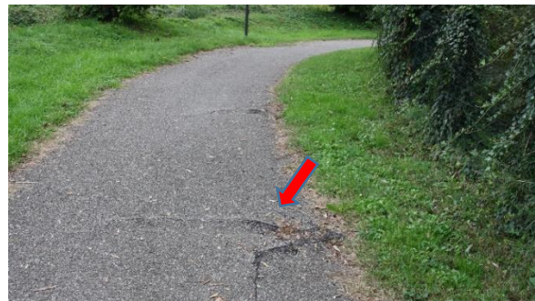
Foto 2 – Pavimentazione dissestata da apparati radicali
