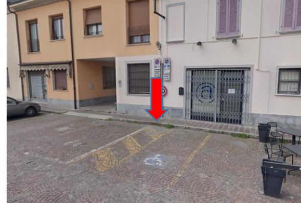
Foto 5 - P.zza V. Emanuele: stallo disabili - dislivello marciapiede
