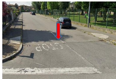
Foto 2: Via Castello - attraversamento pedonale non segnalato
