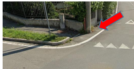
Foto 8: Via Roggetto - percorso pedonale non a norma e ostruzioni nella sezione di passaggio
